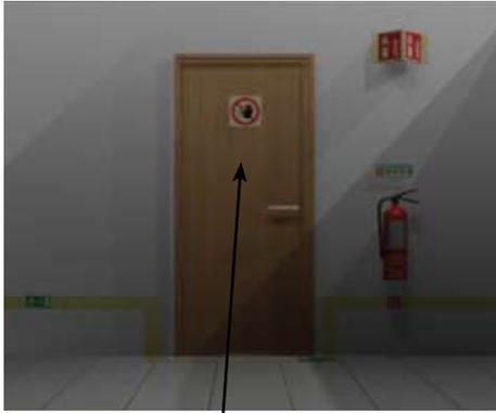
Signal d'évacuation et signal d'extincteur installés entre des bandes photoluminescentes pour indiquer le sens d'évacuation et la localisation de l'extincteur.
