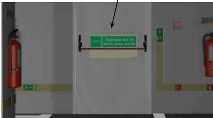
Signalisation d'une porte de sortie de secours (qui s'ouvre du côté droit) avec des signaux et bandes installés dans des rails en aluminium anti-vandalisme.
